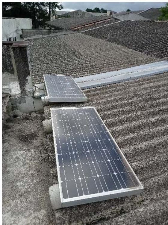
Figura 4.39: Par de módulos fotovoltaicos 490J da Fabricante Ameresco Solar instalados sobre a cobertura do laboratório. Fonte: próprio autor.
